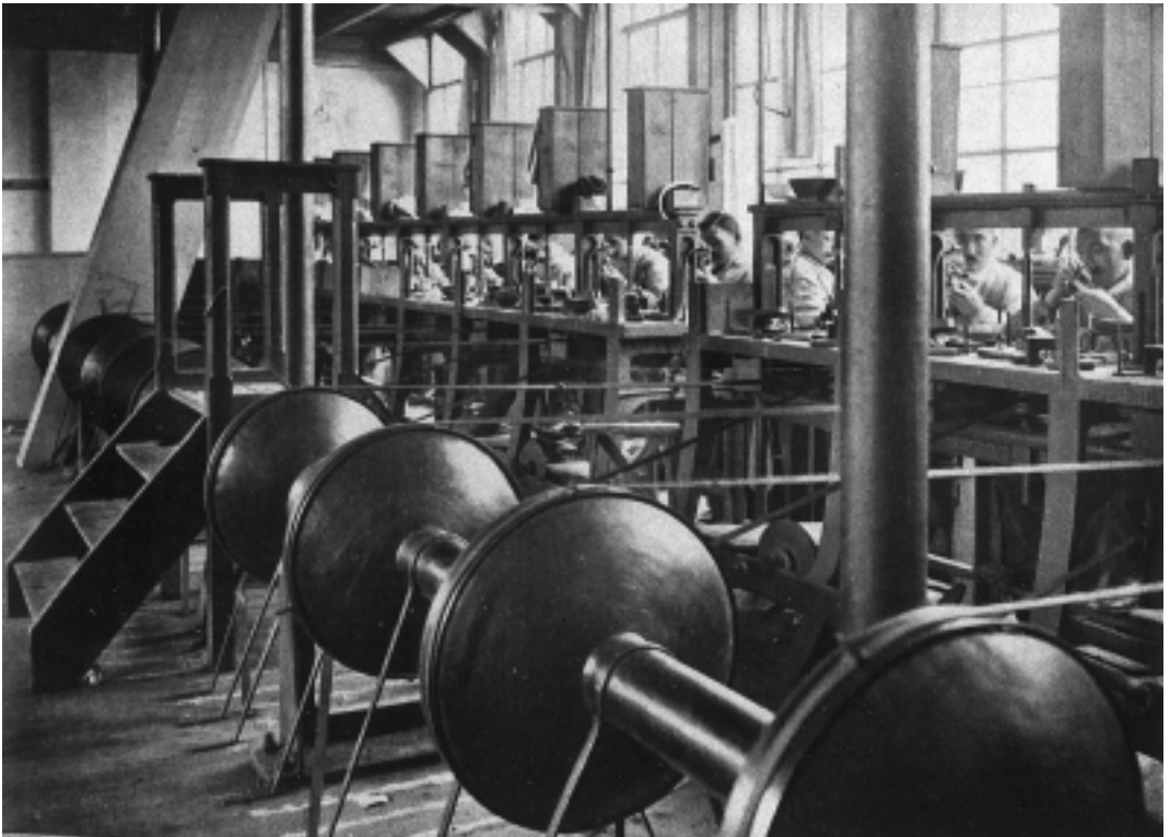
Een slijperij, mogelijk die van Asscher, in Amsterdam ca. 1906. De slijpmolens op de achtergrond worden via riemen, die zijn verbonden met een centrale as, aangedreven door een elders in het gebouw opgestelde stoommachine. (Coll. IISG, Amsterdam)
