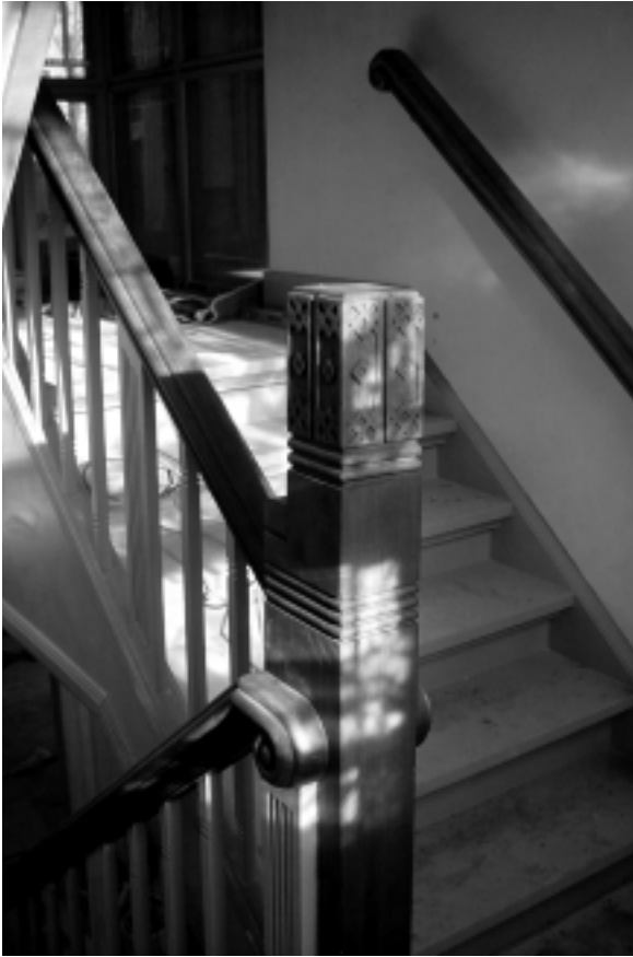
Melina Maas-Elzinga heeft de villa voorzien van enkele Indische elementen zoals het houtsnijwerk in de hoofdtrapbalusters. (foto: EJP)
