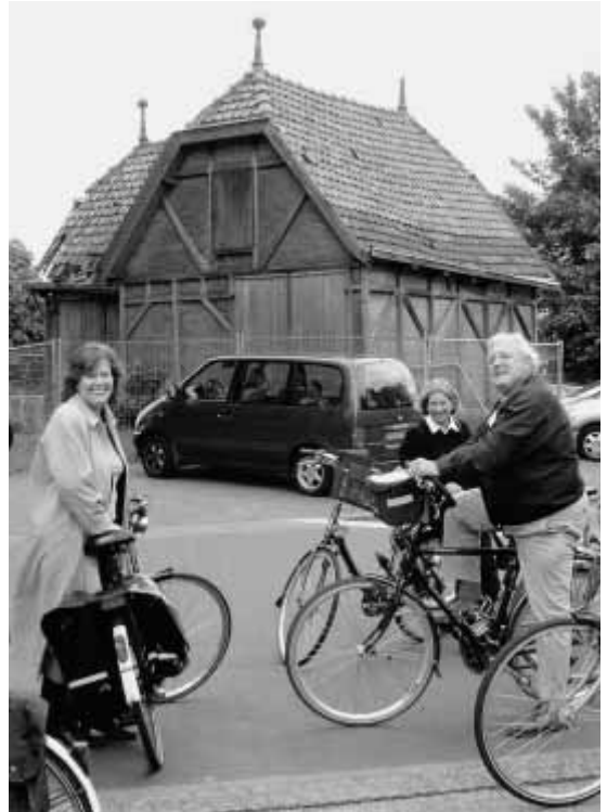
Het storthuisje aan de Vioenstraat vóór de restauratie.
