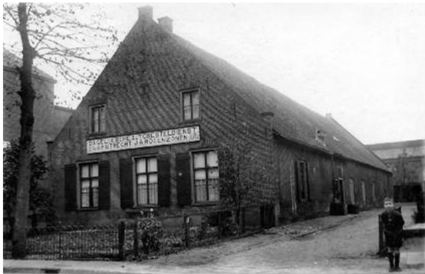
De voorgevel van de voormalige boerderij omstreeks 1930 met de oude roedeverdeling in de ramen.
